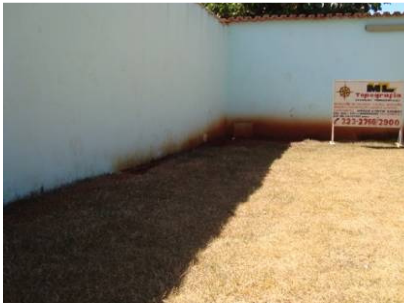
Figura 1. Impacto de uma gota sobre o solo (a); efeito do salpicamento em muro (b).
