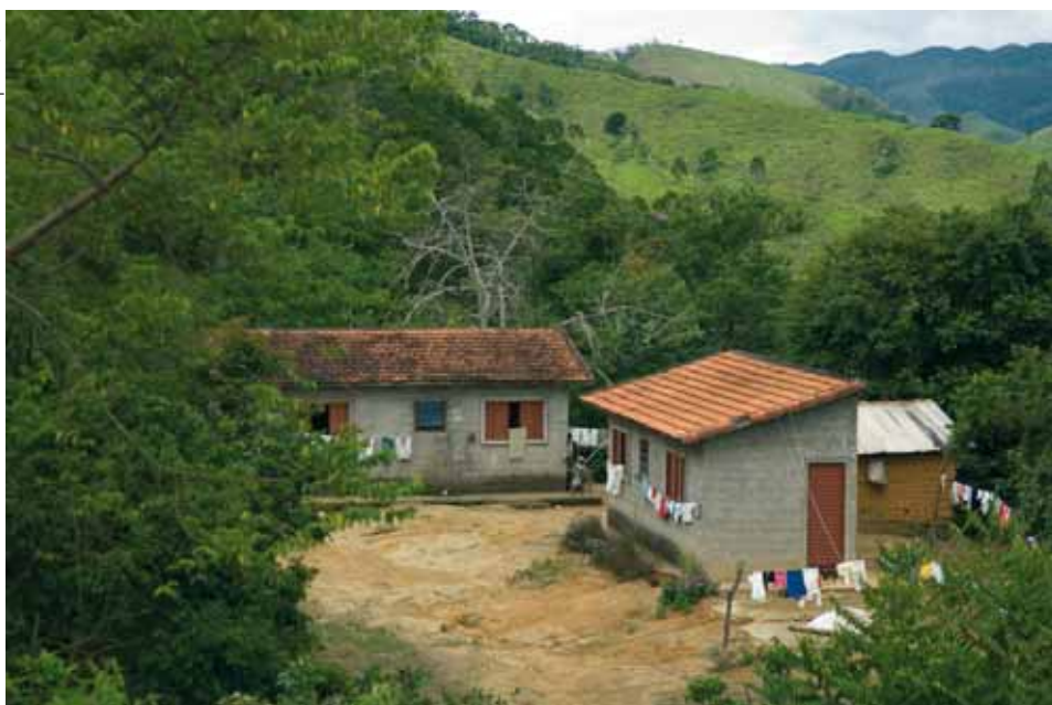
Casa de alvenaria com a cozinha de pau-a-pique.
