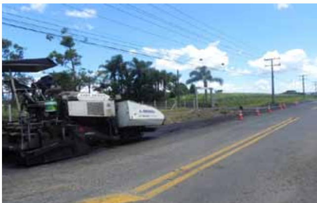
Início das obras na Avenida 25 de julho
