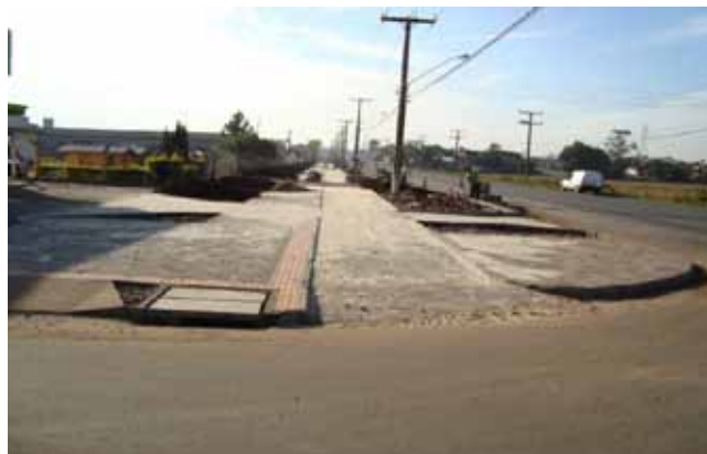
Início das obras na Rodovia Gabriel Arns
