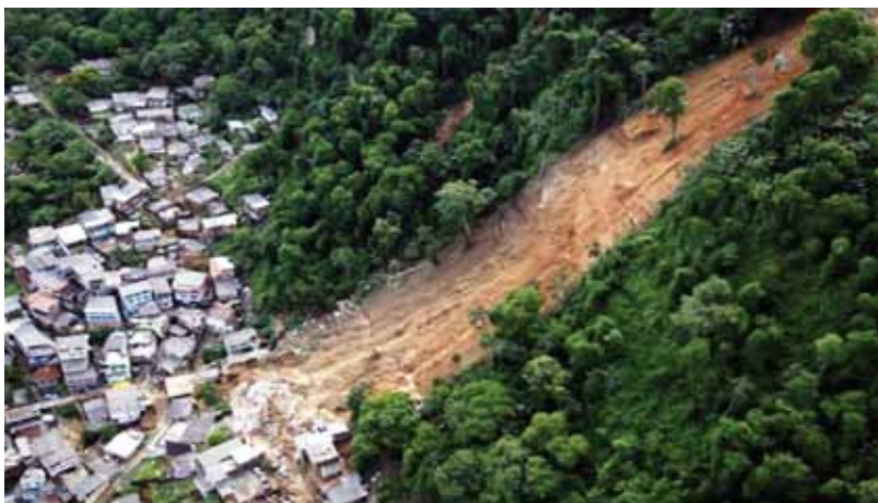
Deslizamento de encosta sobre comunidade (fonte: PCRJ)
