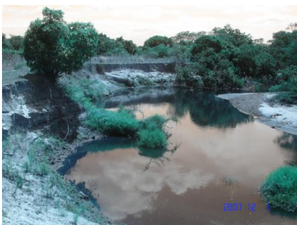
FIGURA 20 – Erosão do Itapicuru-açu em Itiúba
