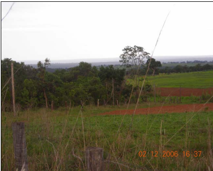
Foto 2: Detalhe da infra-estrutura de energia elétrica construída pelo Projeto Pronaf-SítioNovo-1. Fonte: Foto feita pelo autor em dez.2006.
