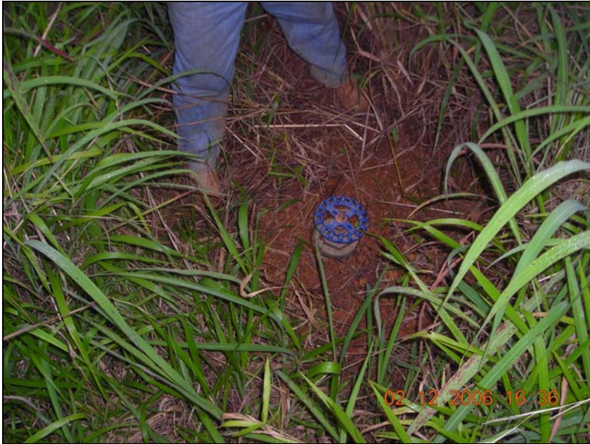
Foto 1: Detalhe do registro do canal de irrigação construído pelo Projeto Pronaf-SítioNovo-1. Um desse para cada 5 a 6 famílias. Fonte: Foto feita pelo autor em dez.2006.
