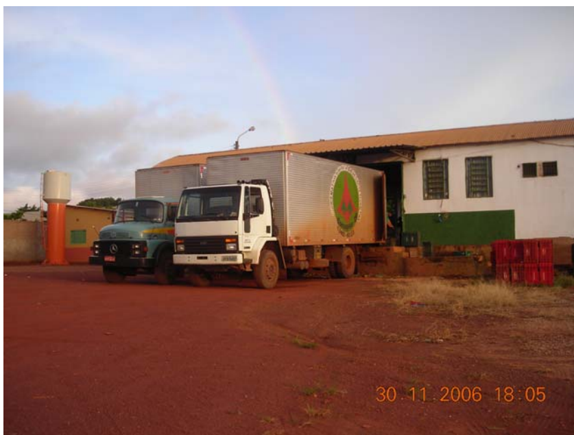
Foto 7: Detalhe (ao fundo) do galpão reformado pelo Projeto Pronaf-Cootaquara Fonte: Foto feita pelo autor em nov.2006.
