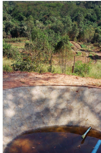
Foto 16 - Tanque de água com horta mandala ao fundo.
