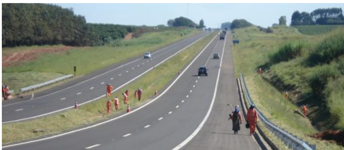
Figura 33: Equipe de trabalhadores exercendo a sua atividade na rodovia.
