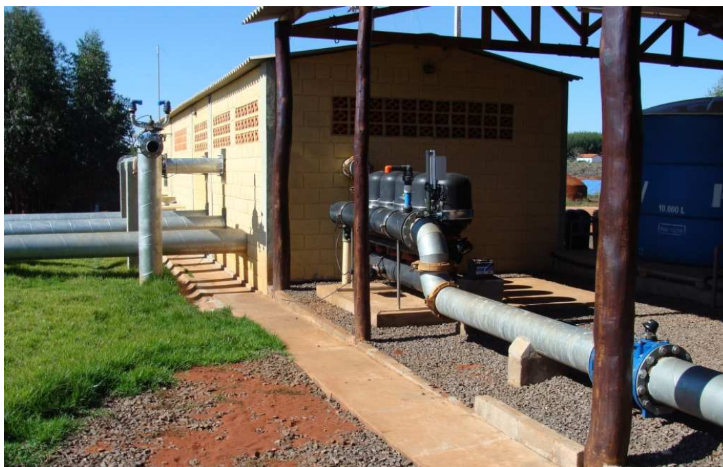
Figura 8. Estrutura de cabeçal de controle do sistema de fertirrigação para produção de madeira de Eucalyptus spp da Empresa MMX Metálicos Corumbá Ltda.
