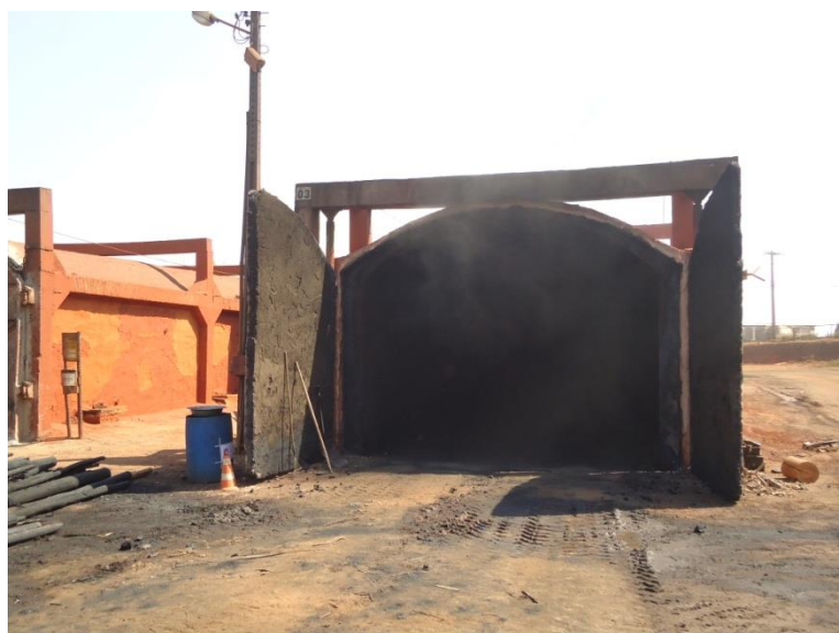
Figura 8 Vista frontal do forno FR 230 utilizado na etapa de carbonização.
