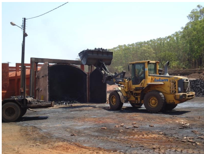
Figura 10 Carregadeira utilizada na etapa de descarregamento do forno
