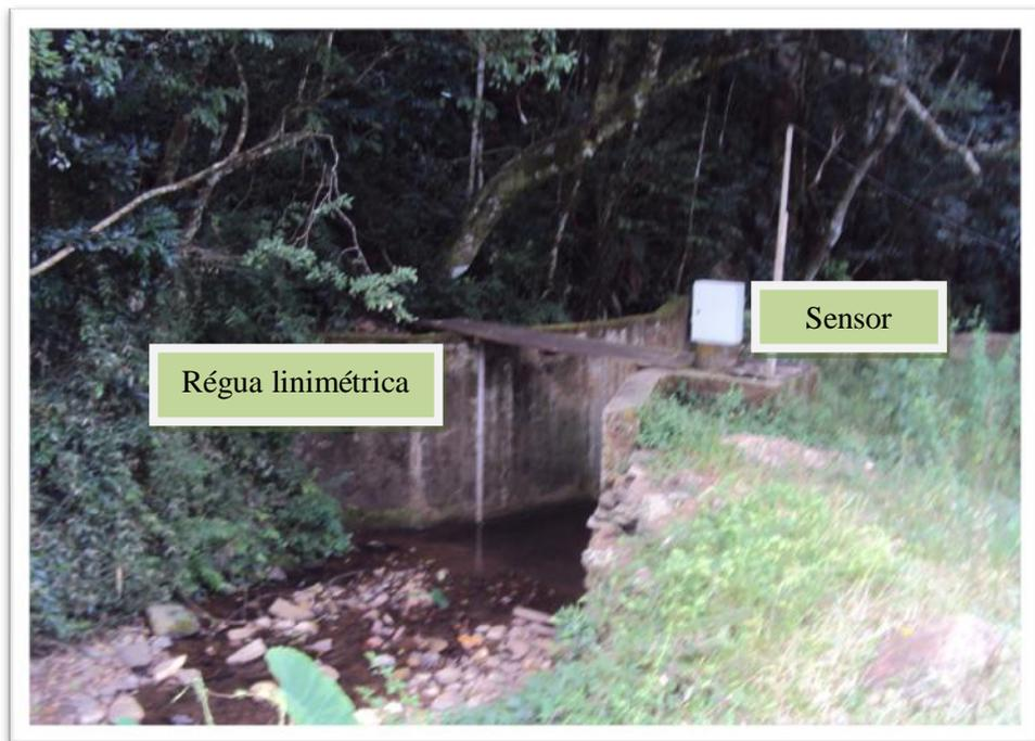
Figura 15: Vista da calha parshall com régua linimétrica e sensor de pressão.
