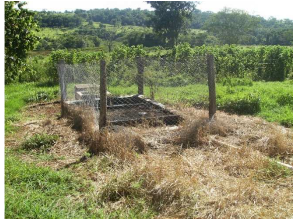
Figura 11 – Decantador de dejetos dos suínos
