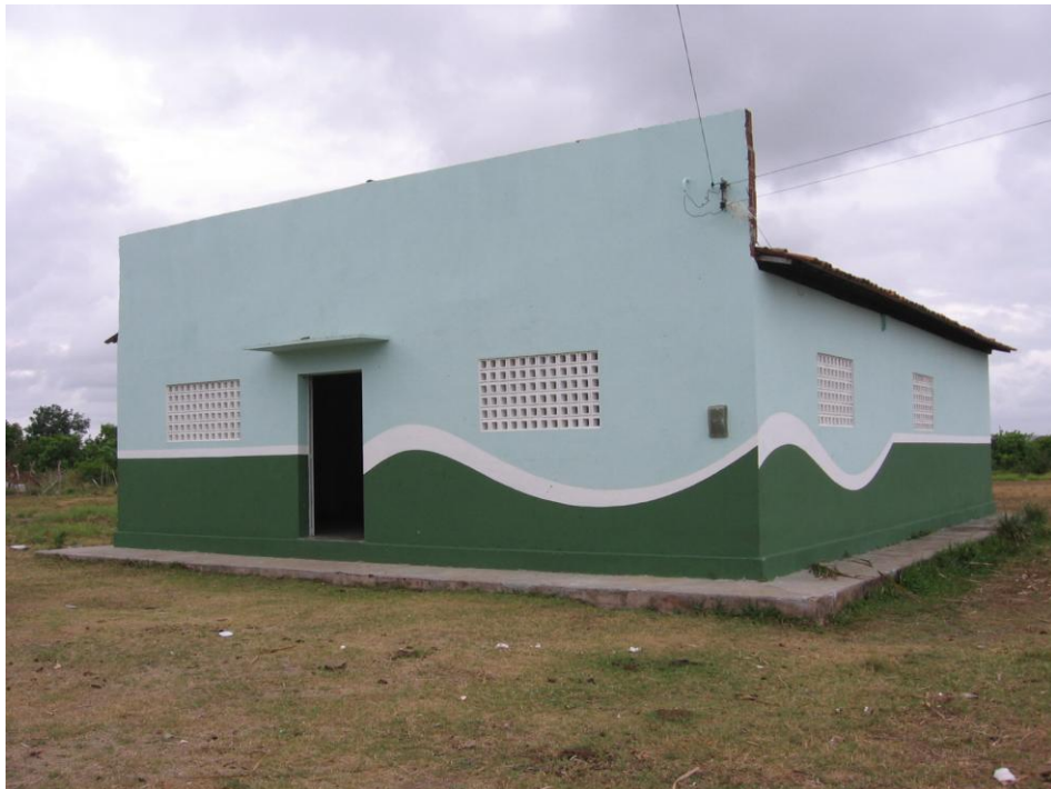
Foto 2. Prédio sede da Associação de Moradores de A-Ver-o-Mar
