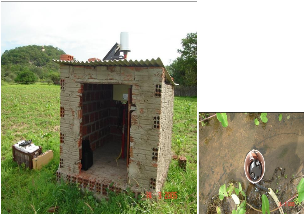
Figura 6: Detalhe da estação automática para coleta dos dados hidrológicos e do sensor de vazão e altura da lâmina de escoamento do riacho Jacu.
