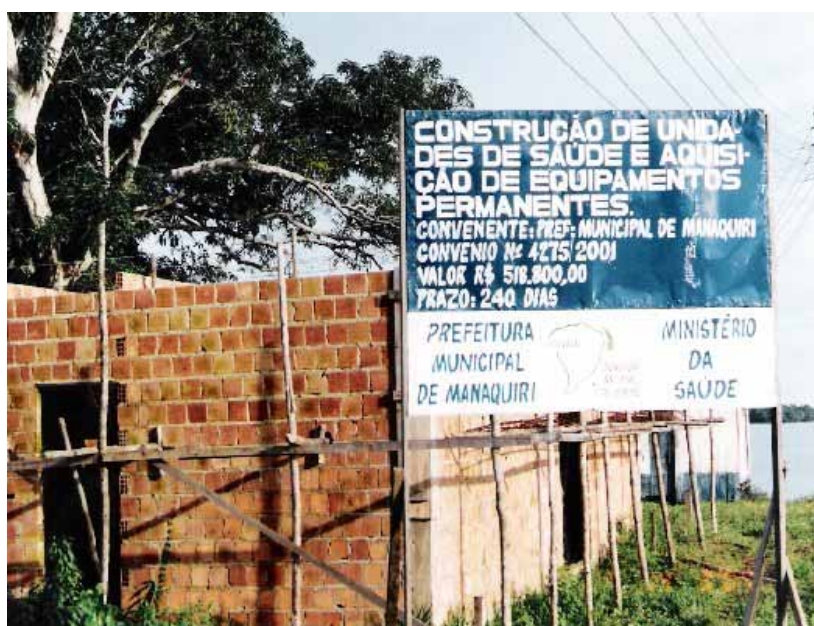
Figura 17 – Construção da unidade de saúde, no Cai N'Água - AM
