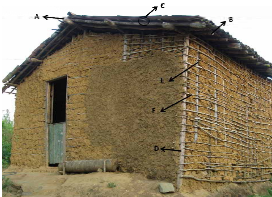
Figura 3. Principais produtos madeireiros empregados na construção de casas. A: Linha; B: Caibro; C: Ripa; D: Esteio; E: Chomel; F: Vara.
