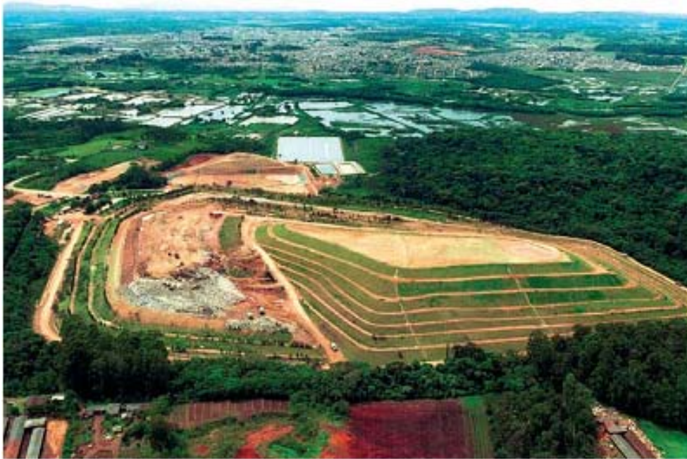
Figura 8. Vista final de um aterro sanitário com os taludes revegetados.
