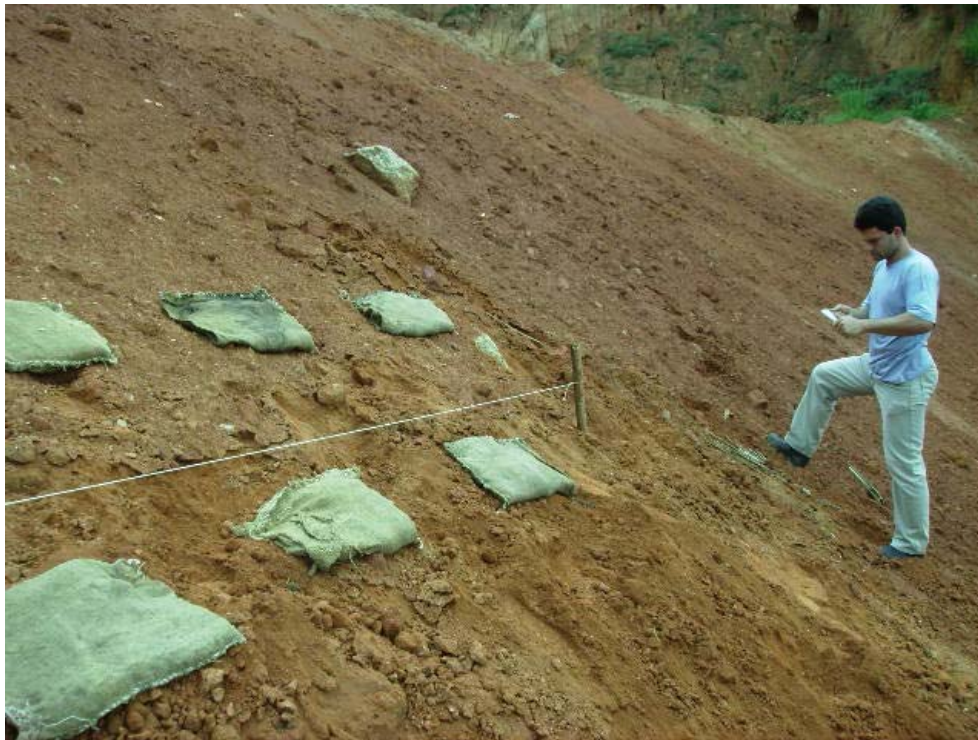
Figura 4. Recobrimento do talude com os sacos de aniagem.
