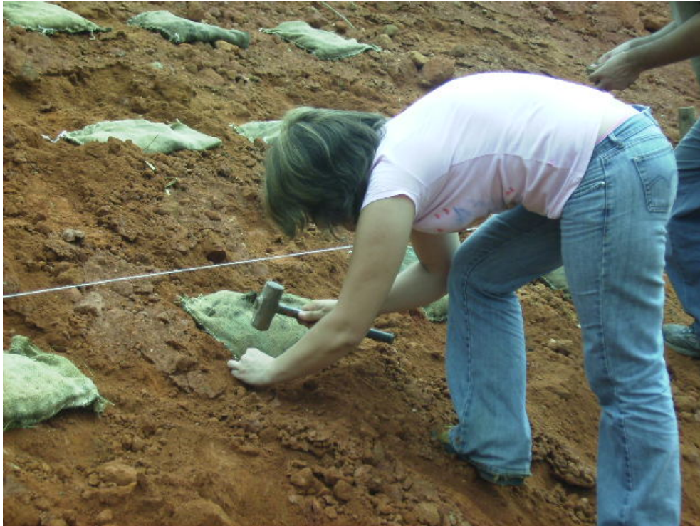
Figura 5. Fixação dos sacos de aniagem no talude.
