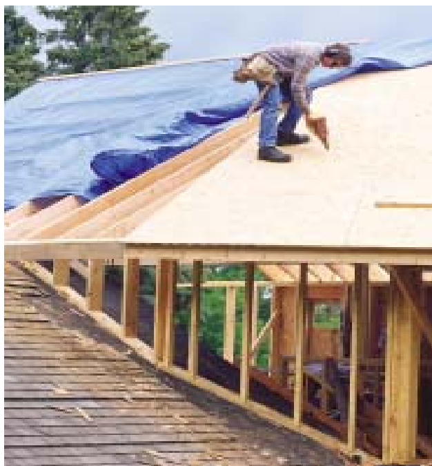
Figura 7. OSB Home: versatilidade no uso em pisos e telhados. Fonte: SBA, 2005 – www.osbguide.com .
