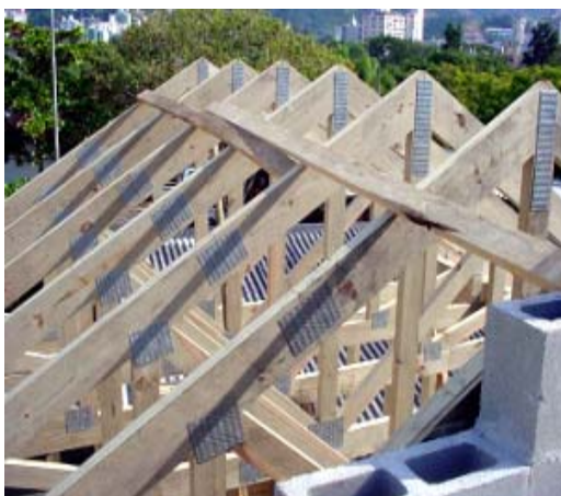
Figura 10. Modelo de tesoura em “W” para confecção de telhados. Fonte: www.habitare.org.br
