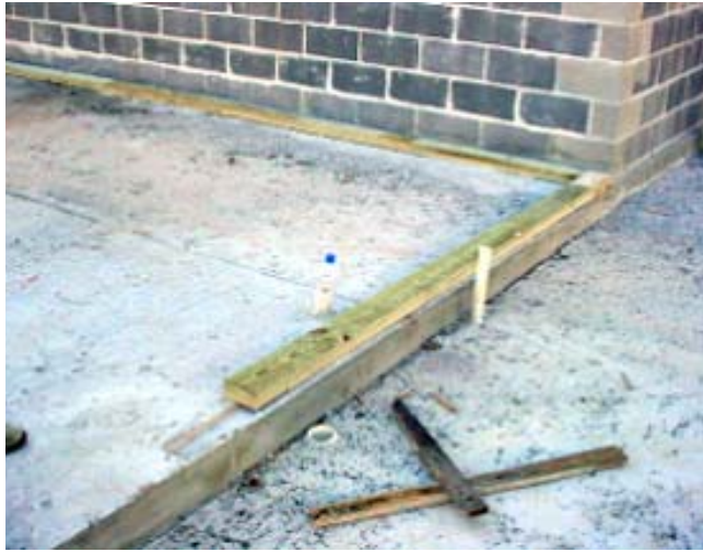
Figura 2. Exemplo de “radier” - uma espécie de laje batida no chão. Fonte: www.habitare.org.br .
