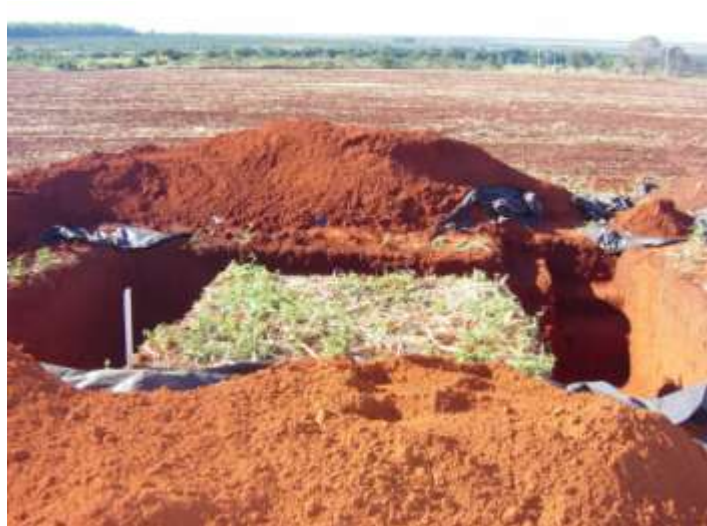
Figura 4.5 - Trincheira aberta para a instalação das calhas de coleta de escoamento subsuperficial.
