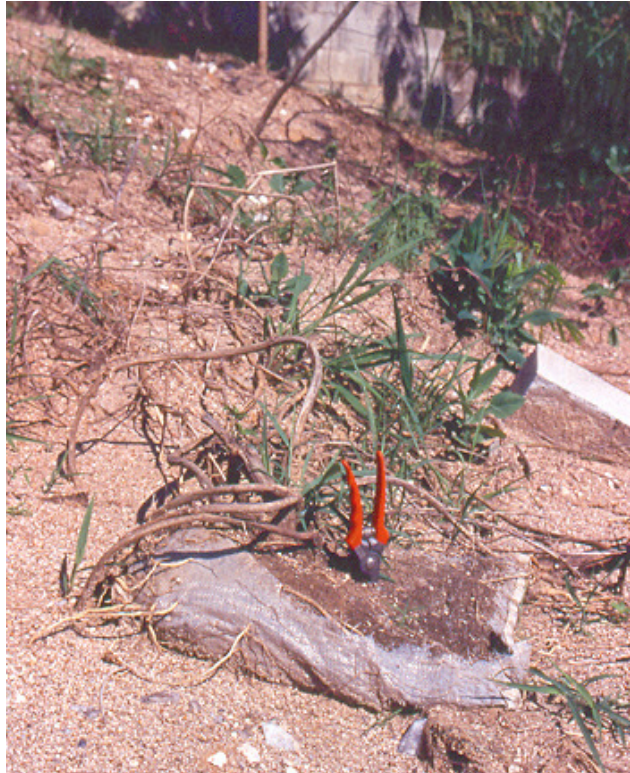
Foto 09: Medida físico-biológica (almofada), utilizada no PRAD das Áreas de Empréstimo na Ilha da Madeira, Itaguaí, RJ.
