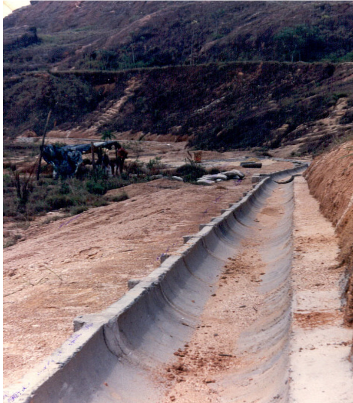
Foto 07: Medida Física (Calha), sendo implantado no PRAD da Área de Empréstimo em 1993, Ilha da Madeira, Itaguaí, RJ.
