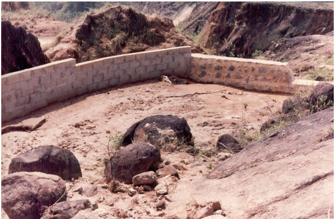
Foto 06: Medida Física (Muro de contenção), sendo implantado no PRAD da Área de Empréstimo em 1993, ilha da Madeira, Itaguaí, RJ.
