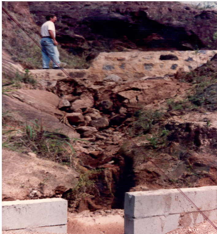
Foto 8: Medida Física (Dique), sendo implantado no PRAD da Área de Empréstimo em 1993, ilha da Madeira, Itaguaí, RJ
