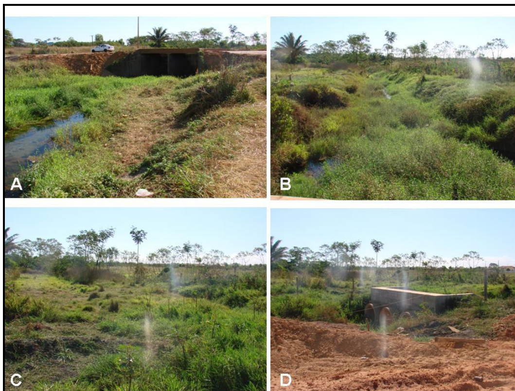
FIGURA 28 – SUPRESSÃO DA MATA CILIAR DO CÓRREGO MARLENE. (A) PONTE CONSTRUÍDA PARA DAR CONTINUIDADE AO CÓRREGO COM A ABERTURA DA RUA, (B,C) SITUAÇÃO DA MATA CILIAR DO CÓRREGO APÓS CONSTRUÇÃO DA RUA E DOS LOTEAMENTOS, (D) TUBULAÇÃO PARA COLETA DE ÁGUA PLUVIAL DA RUA PARA DENTRO DO CÓRREGO. FONTE: KUNTZ (2008)
