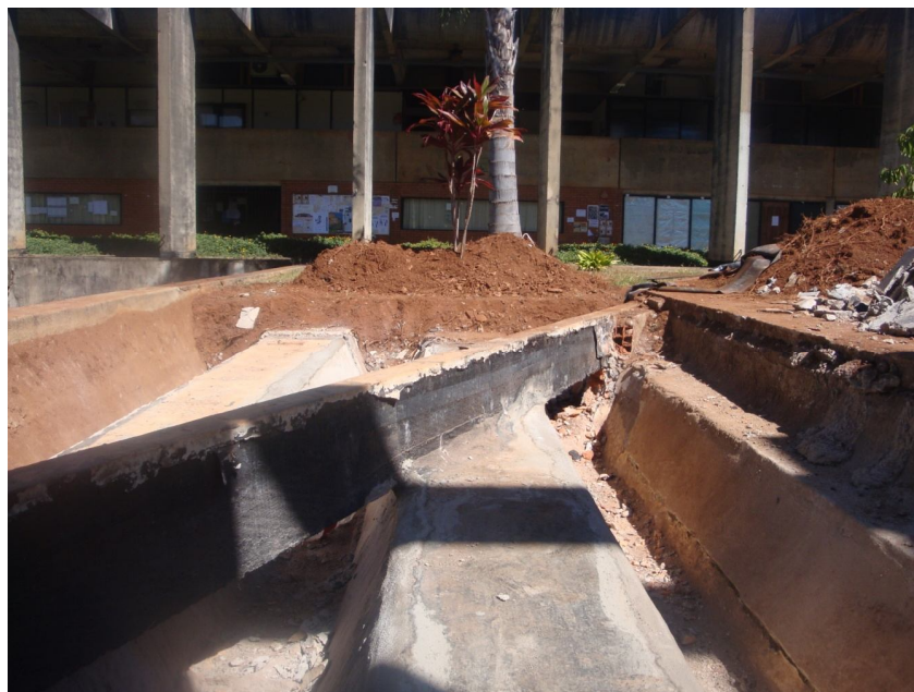
Figura 5 - Laje do jardim.
