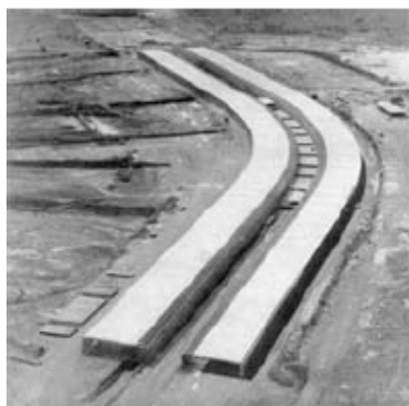
Figura 2 - Instituto Central de Ciências – ICC.
