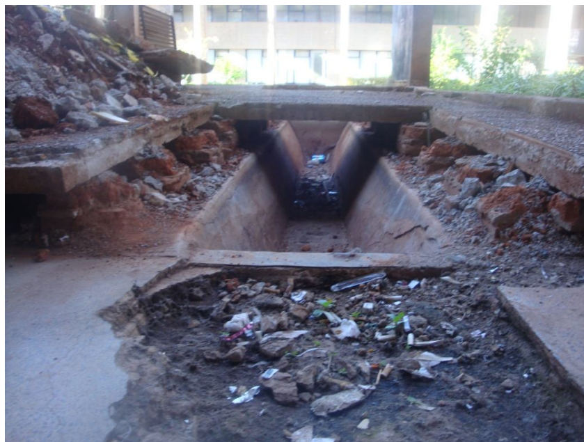
Figura 6 - Remoção do acesso à parte elevada dos jardins.
