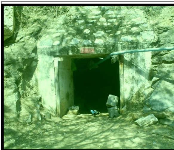
Figura 3: Entrada do túnel da Mineração Tomaz Salustino. Fonte: Autora, 2011.
