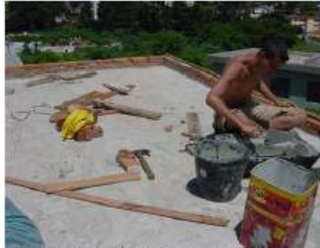
Figura 3.1 – Assentamento de tijolos.
