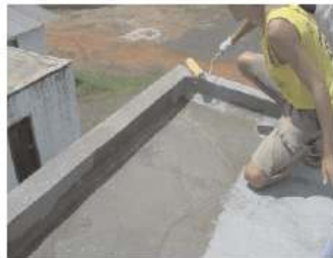
Fig. 3.4 – Aplicação do Impermeabilizante.
