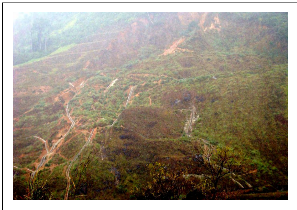
Figura 2.11 Obras especiais para controle de drenagem no talude natural.
