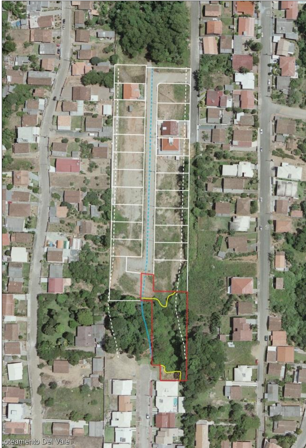
Figura 12: Loteamento Del Vale onde houve processo de intervenção para a canalização de corpo hídrico.
