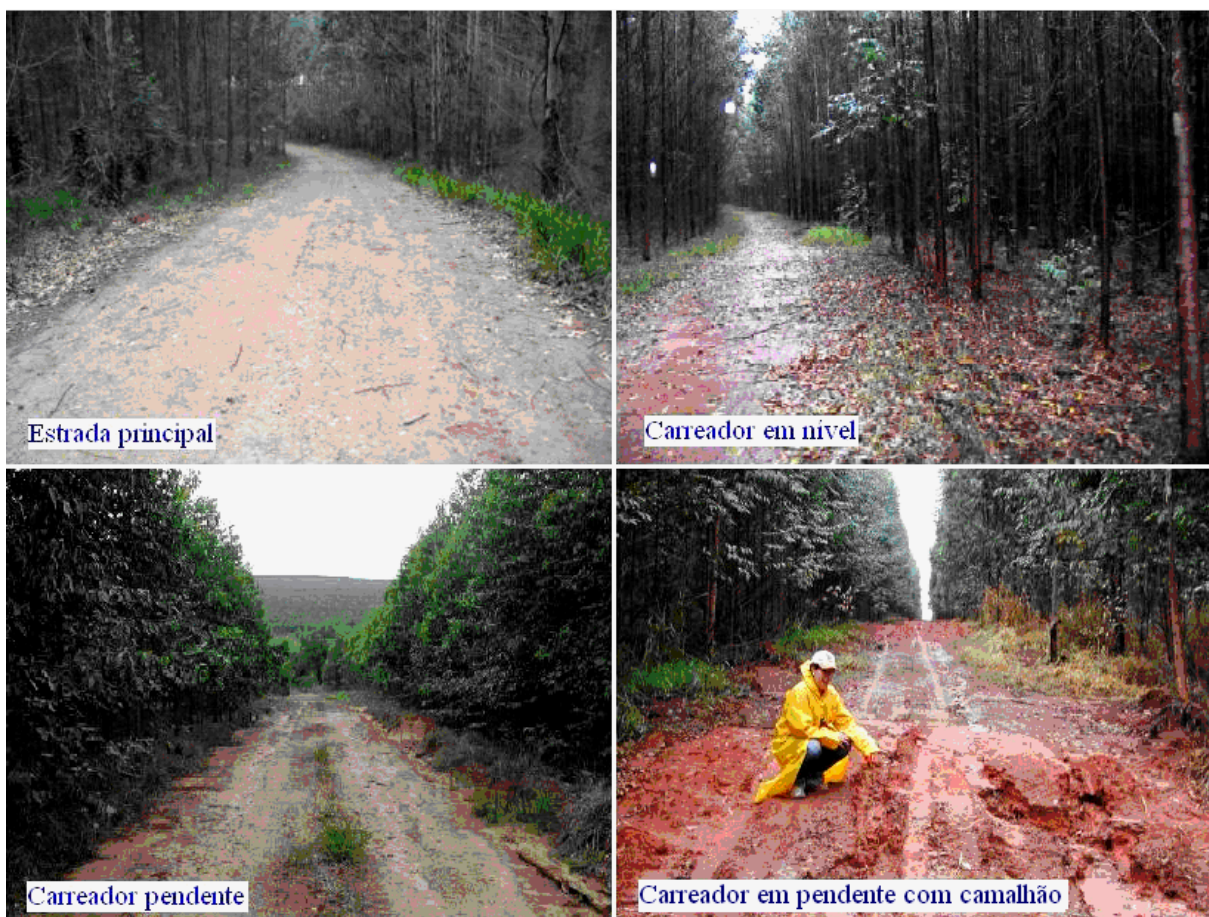
Figura 20: Estradas da rede viária em nível.
