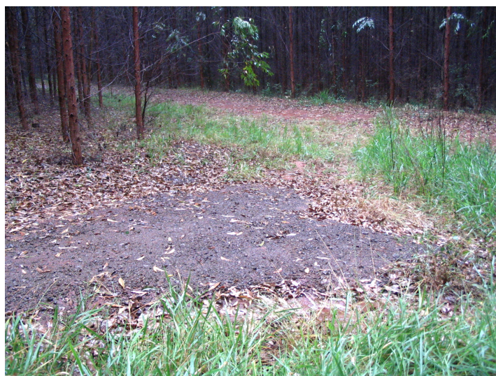
Figura 13: Passagem molhada ao final de um carreador em nível.
