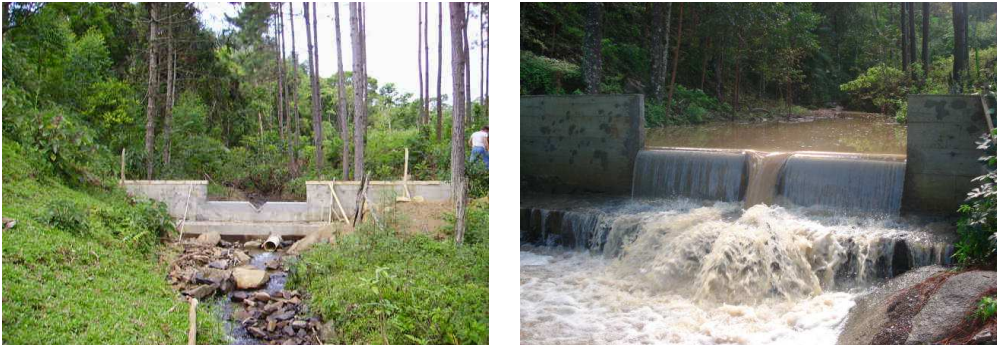
Figura 2.5. Vertedor misto construído no ponto 3 da bacia do Ribeirão Concórdia
