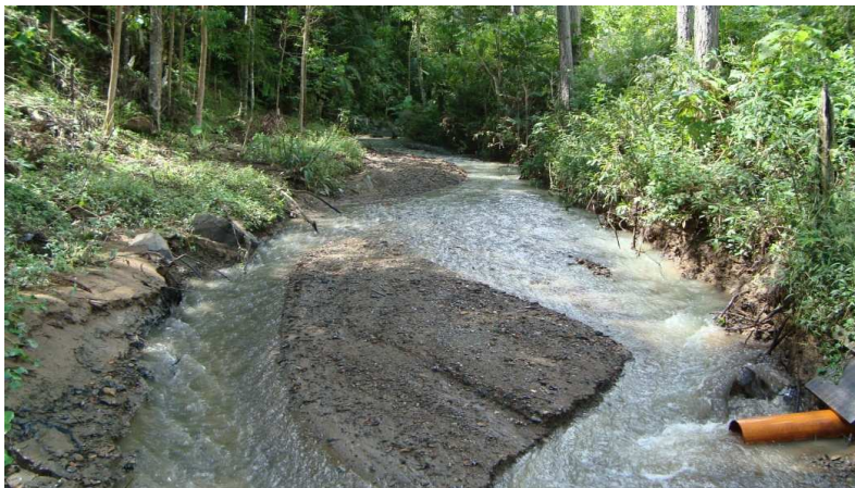
Figura 6.2 – Depósito de sedimentos formado à montante do vertedor
