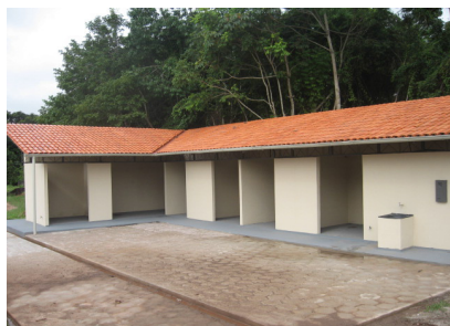
Figura 1. Prédio para o gerenciamento dos resíduos sólidos (Geressol).
