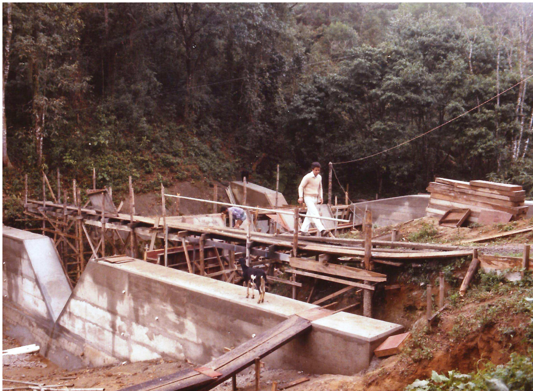
Figura 6. Vista parcial da estação fluviométrica e a esquerda o vertedouro triangular.
