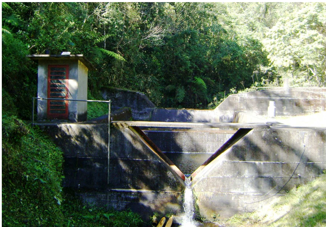
Figura 9. Estação fluviométrica da microbacia hidrográfica experimental B. Em primeiro plano o vertedouro triangular 90° e a esquerda o abrigo do linígrafo, em 2012.
