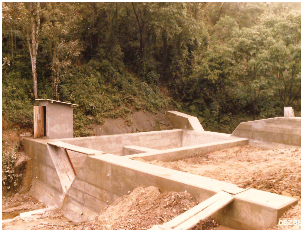
Figura 7. Vista da estação fluviométrica, com os dois tanques de sedimentação e tranquilização. À esquerda o abrigo dos equipamentos.
