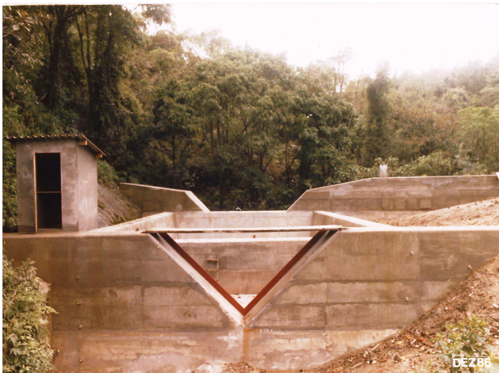
Figura 8. Vista frontal da estação fluviométrica em fase final de construção.
