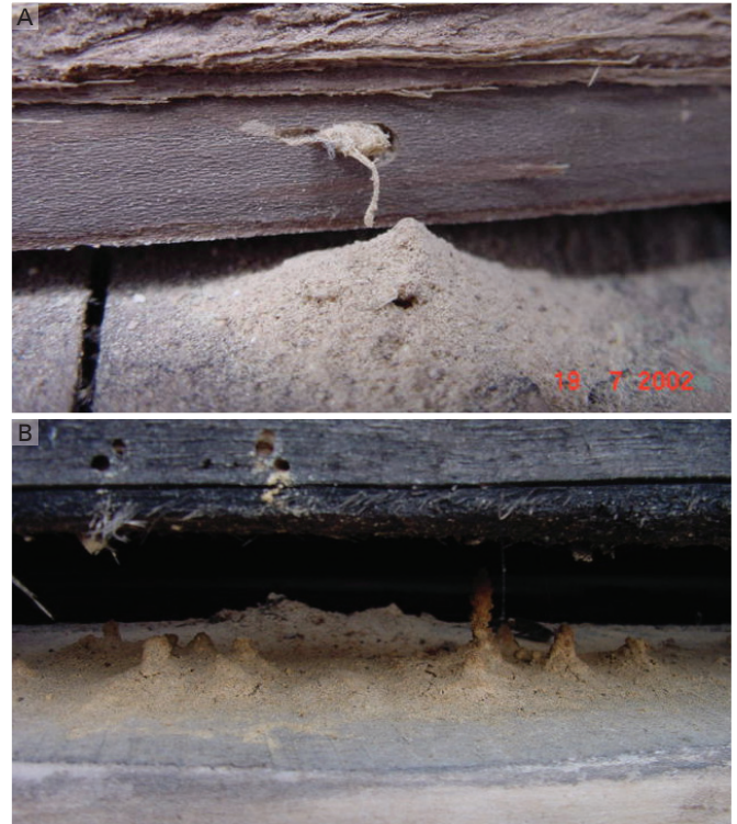
Figura 3. Serragem expelida de (A) um ponto e (B) vários pontos de ataque de S. conigerum . Mato Grosso, julho de 2002.
