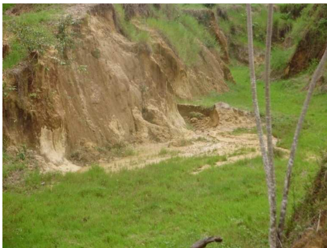
Figura 22- Aspecto do processo erosivo evidenciado na nascente do rio Apeú Fonte: Registrado por SOUZA, S. R. 2010
