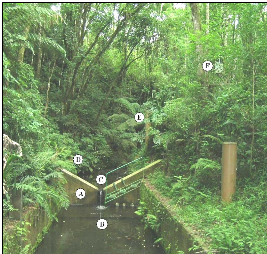
Figura 4 – Estação limimétrica da microbacia Colônia – eflorestamento de Pinus taeda . A = vertedor triangular; B = Plataforma de sedimentação; C = Tanque principal de sedimentação e tranqüilizador do fluxo; D = Régua limimétrica; E = Cilindro de abrigo do linígrafo; F = Caixa do datalogger
