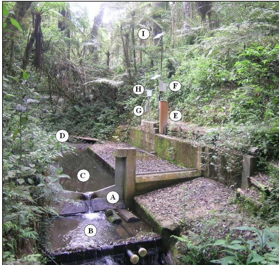
Figura 3 – Estação linimétrica da microbacia Mortandade – Mata Atlântica. A = vertedor composto; B = Plataforma de sedimentação; C Tanque principal de sedimentação e tranquilizador do fluxo; D = Régua linimétrica; E = Cilindro de abrigo do linígrafo; F = Caixa do datalogger ; G = Pluviômetro para coleta de água; H = Pluviógrafo; I = Painel solar
