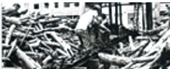
(E) Cominuição dos descartes transformados em serragem
