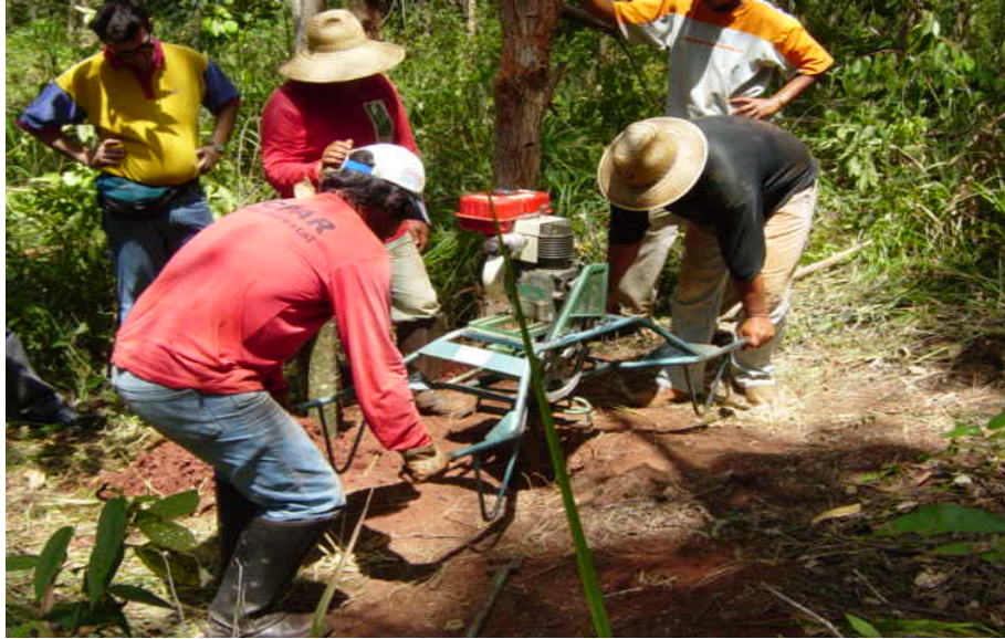
Figura 7 – Instalação dos poços piezométricos
