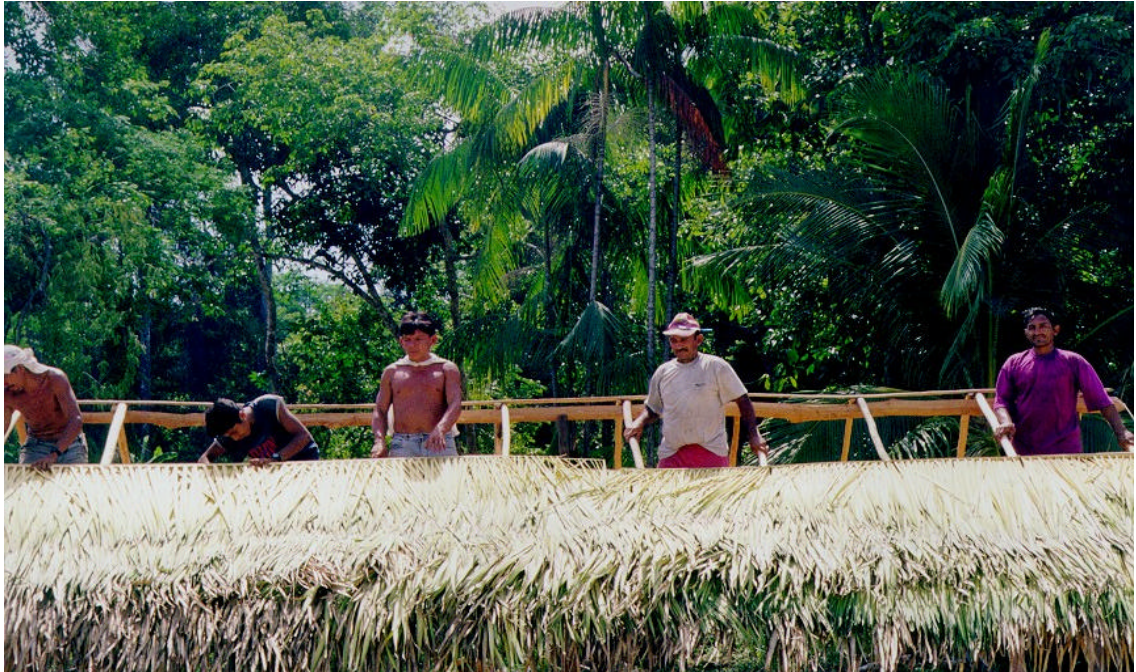
Figura 12 - Mutirão para construção de um barracão de festas
