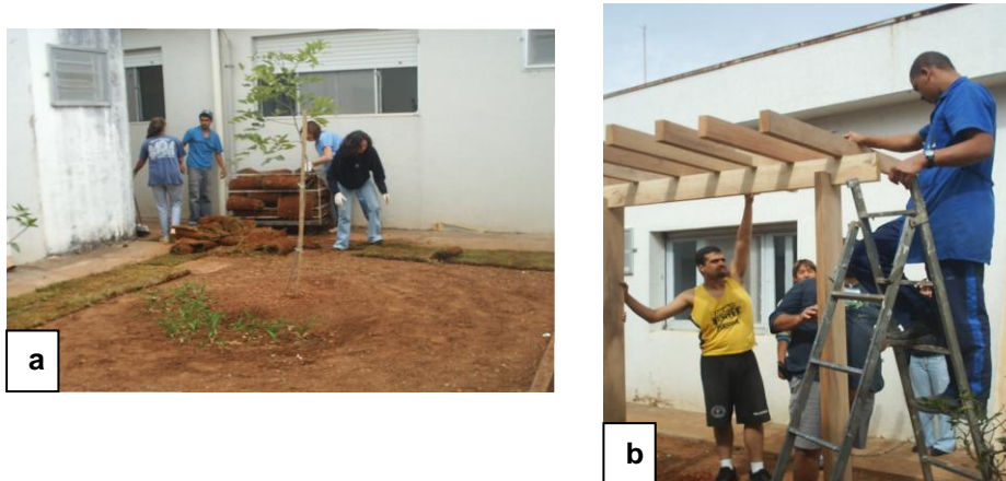
Figura 2.3 (a) e (b) - Espaços livres existentes entre as alas de internação B e C, na fase de execução dos jardins
