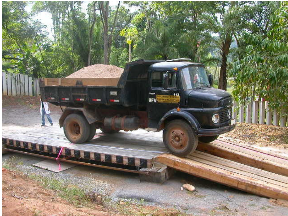
Figura 15 – Blocos formando o encontro da ponte e a rampa de subida do veículo.
