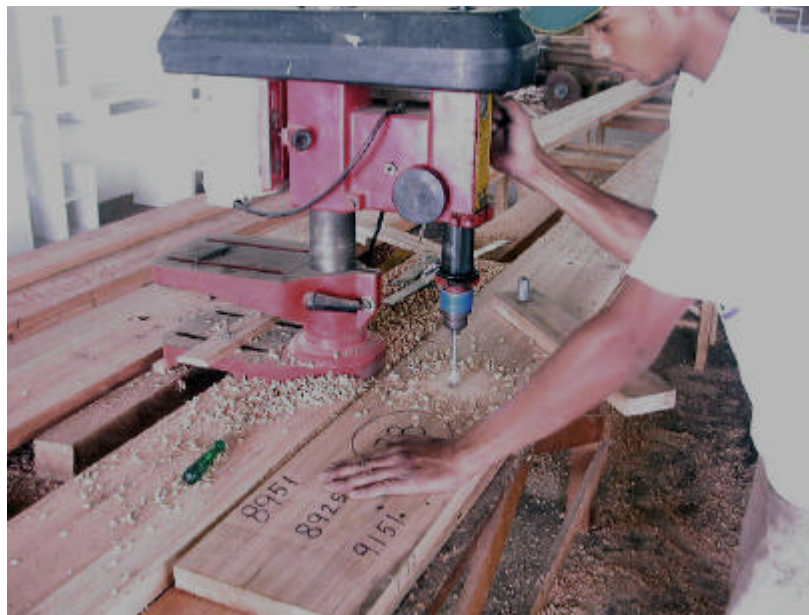
Figura 13 – Perfuração das tábuas.
