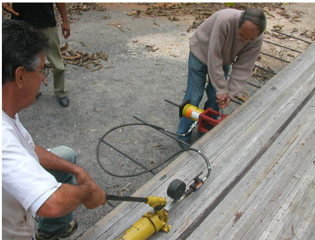
Figura 14 – Tensionamento das barras, vendo-se o cilindro hidráulico vazado e sua bomba.
