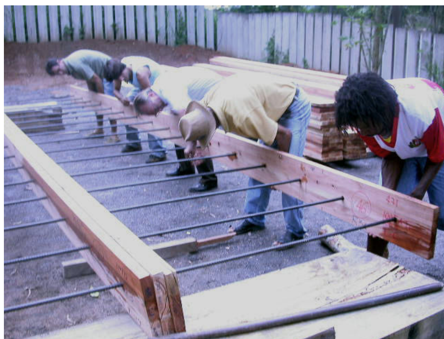
Figura 12 – Colocação das tábuas nas barras.
