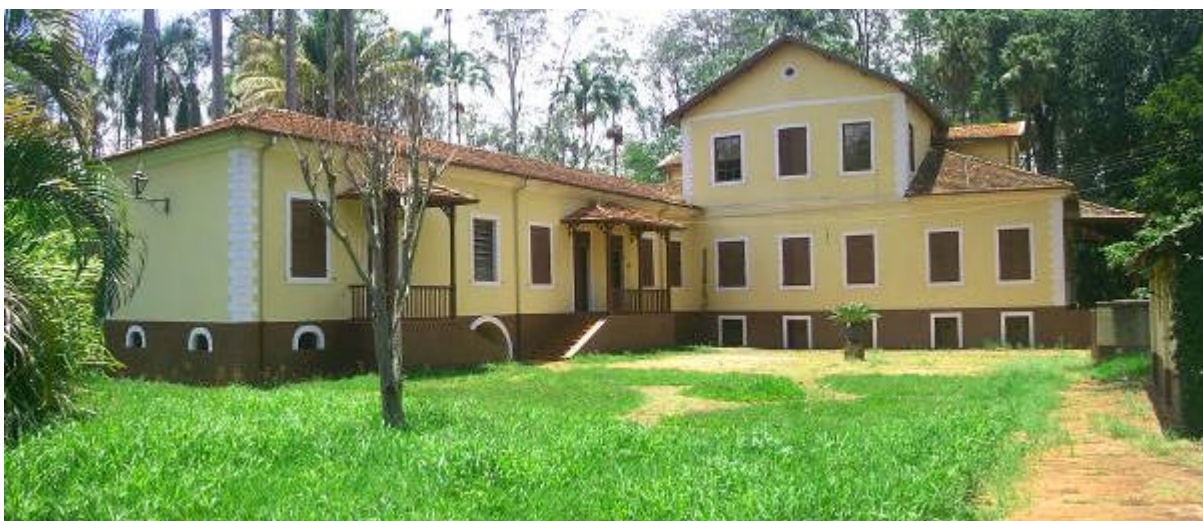
FIGURA 24 – SOLAR “EDMUNDO NAVARRO DE ANDRADE”, VISTO DOS FUNDOS (Augusto J. Martini, dez. 2003)
