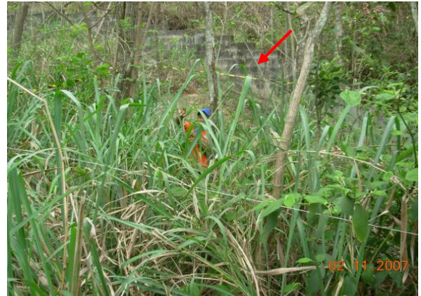
Muro de desvio, 2007. (A')
