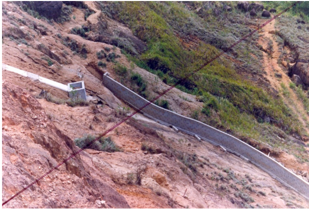
Caixa dissipadora e muro de desvio em 1993. (A)
