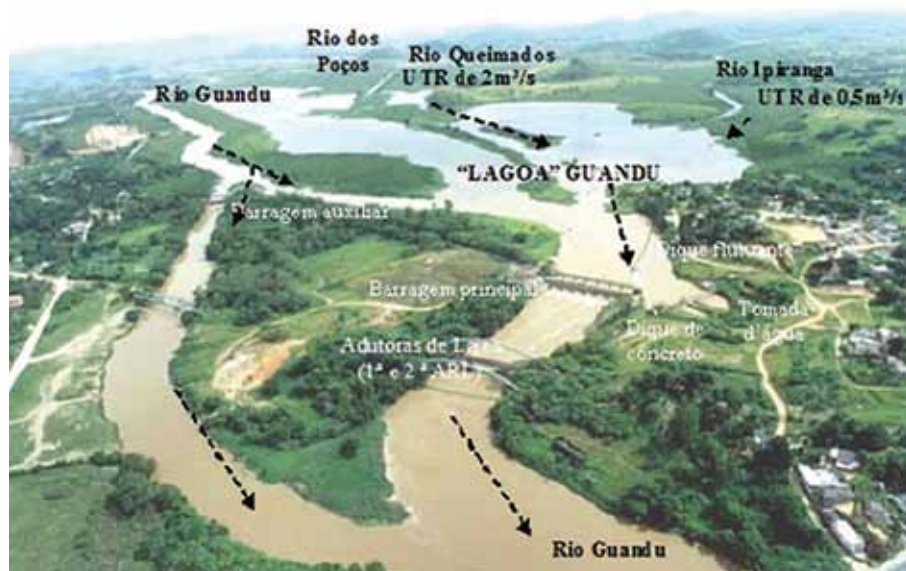
FIGURA 4 - Foto da tomada d'água da ETA Guandu e do local de implantação das UTRs propostas
