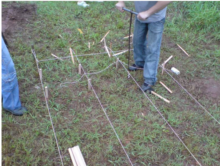
Figura 28 – Instalação do campo de apodrecimento em campo aberto (Fonte: autor)
