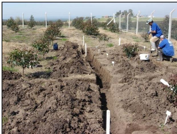
Figura 6.3 – Abertura das valas para colocação dos canos de PVC.
