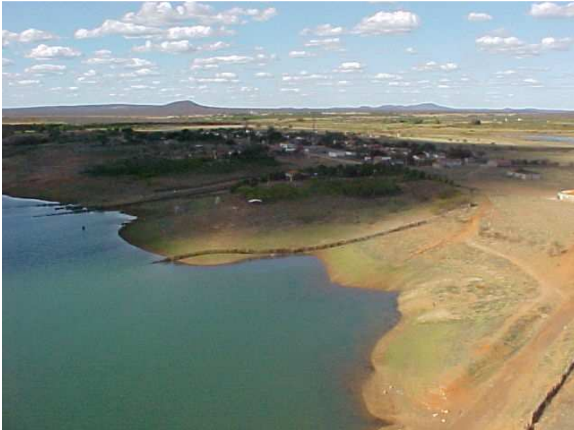
Foto 209 Vista geral do Distrito de Nova Santana, município de Casa Nova. Em primeiro 126a plano vê-se a área de repasse de Sobradinho e muitas cercas indevidas, já as Pt. 216 terras da borda do lago são de domínio da União e responsabilidade da CHESF.
