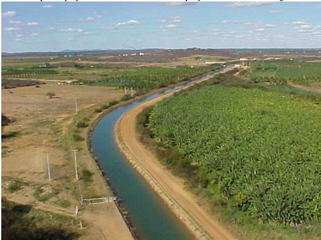
Foto 216 Projeto de Irrigação Senador Nilo Coelho – vista do canal principal (UTM 131 a 8966/310), na periferia da cidade Petrolina: grande plantio irrigado de banana. Pto. 230
