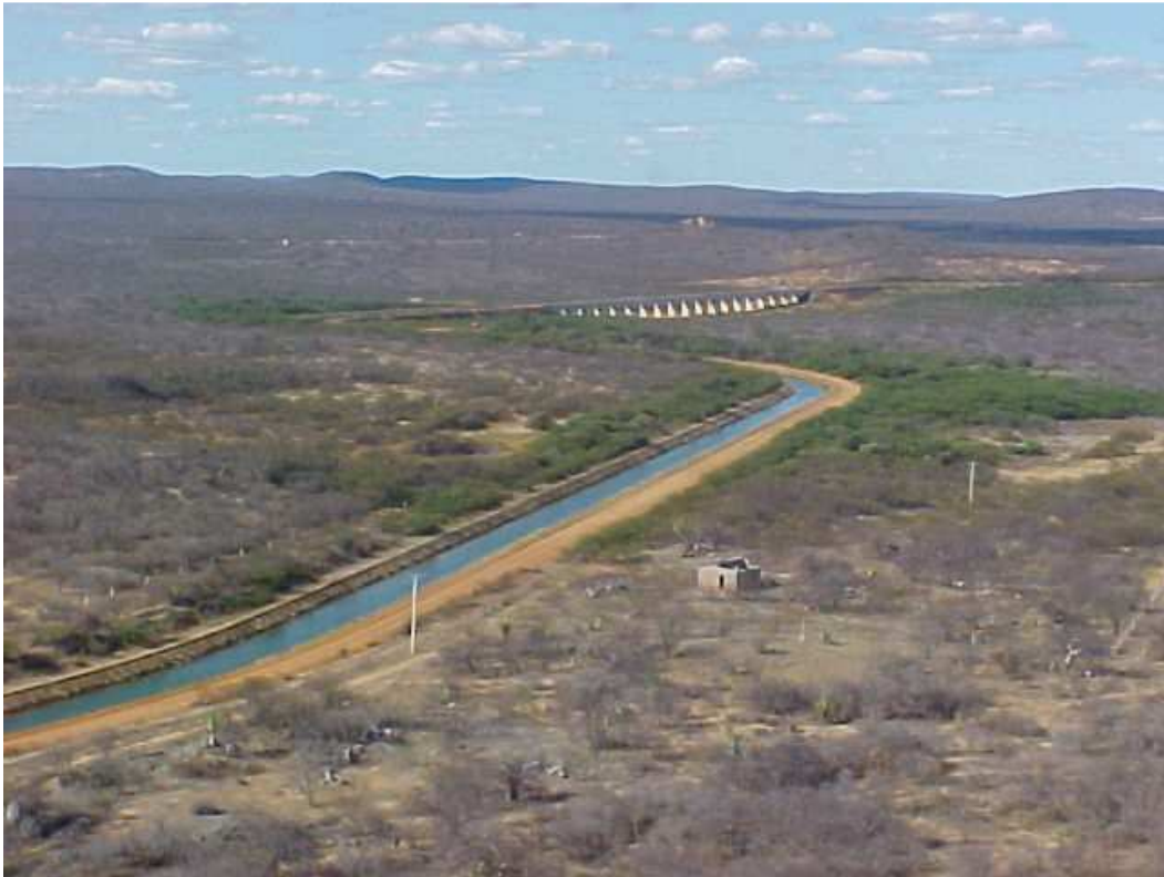
Foto 215 Canal de Irrigação Senador Nilo Coelho – município de Petrolina: um dos 128a maiores pólos de produção de fruticultura irrigada do Brasil. A vazão captada Pto. 223 para o projeto é da ordem de 23\text{m}^3/\text{s} e o preço é de R$13,00/ha irrigável/mês.
