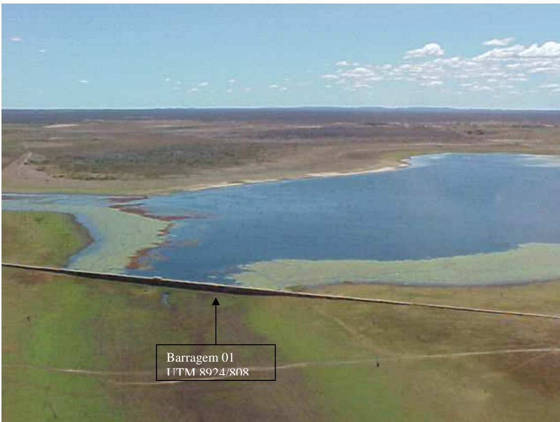
Foto 112 Barragem de espera na região de Capim Grosso, município de Remanso que só enche quando o reservatório da UHE de Sobradinho atinge a cota máxima. 66a Pt 163/96
