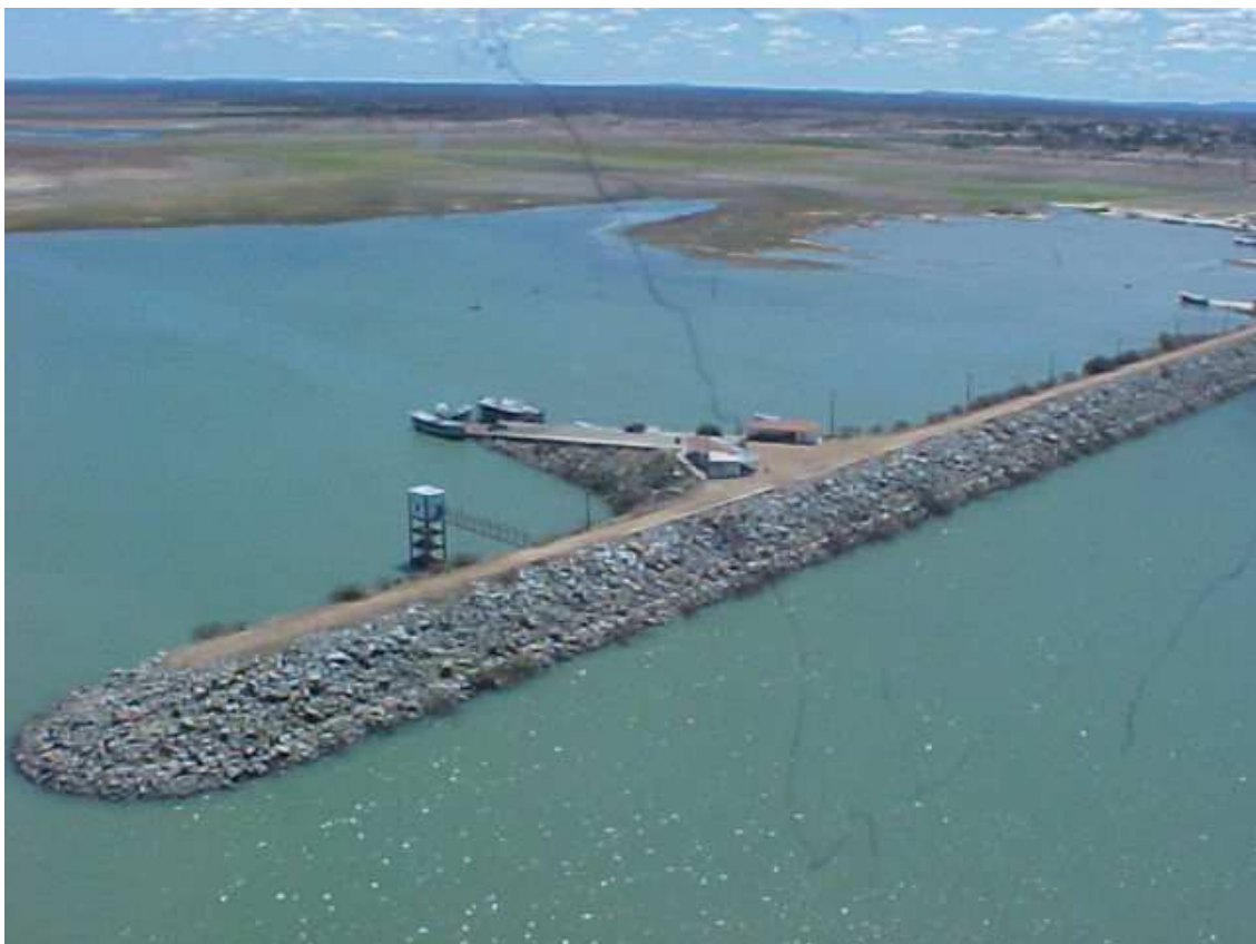
Foto 120 Cais do porto de Remanso, destacando, em primeiro plano, às margens do lago de Sobradinho, a estação de captação de água da cidade, que (UTM 8932/820)
