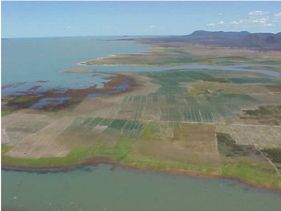
Foto 143 Vista panorâmica da faixa de deplecionalmento do reservatório de Sobradinho 28a na região do Tourão (área de repasse). Pt169/42/43 UTM 8932/819
