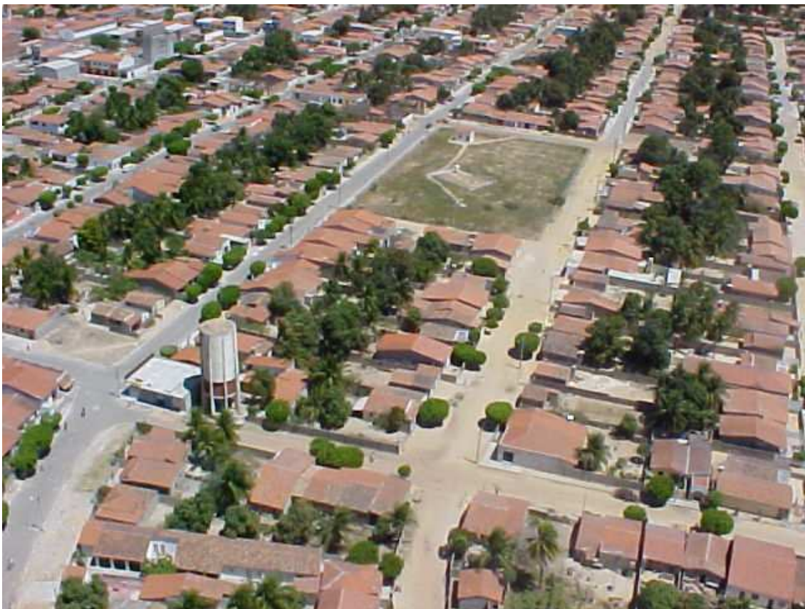
Foto 122 Caixa d'água da cidade de Remanso. 76a Pt 110
