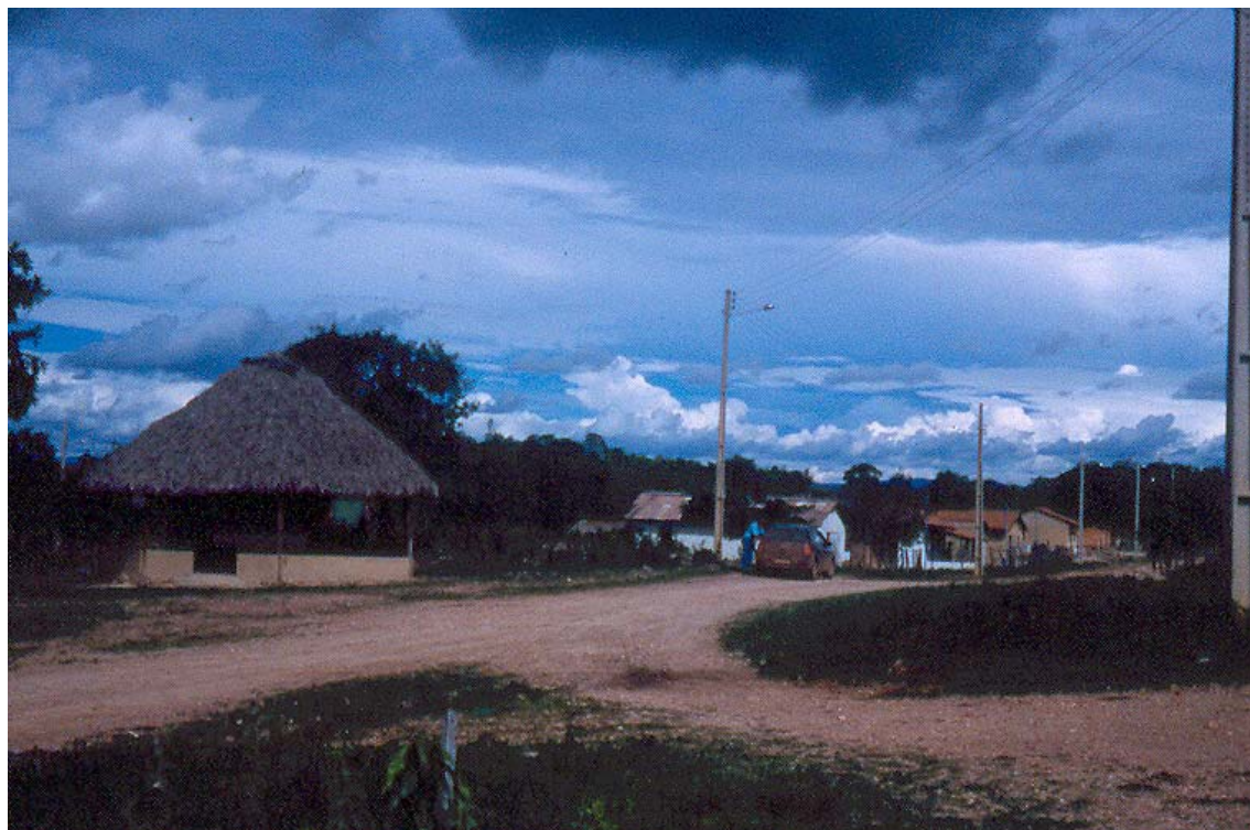
FIGURA 42 - FOTO DA LOCALIDADE DA PONTE DO RIO PRETO, ENTORNO DO PARQUE NACIONAL DA CHAPADA DOS VEADEIROS
