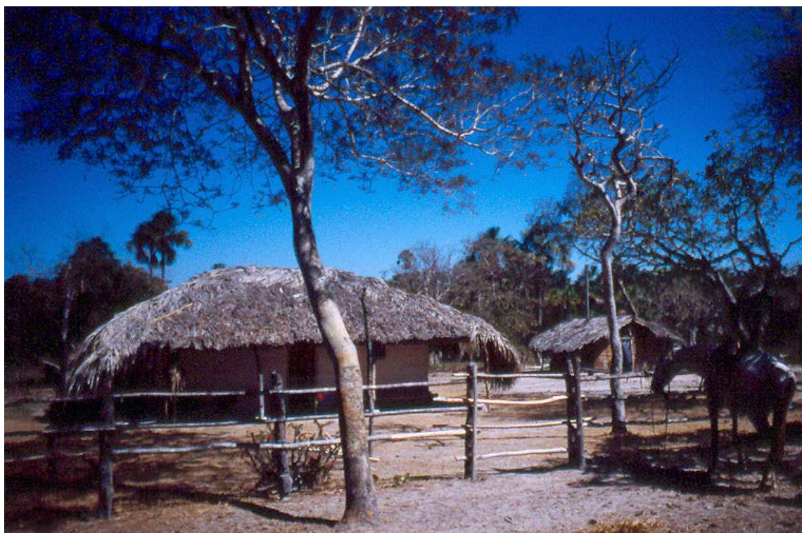
FIGURA 34 - FOTO DE EDIFICAÇÃO NA LOCALIDADE DE TRÊS IRMÃOS, PARQUE NACIONAL GRANDE SERTÃO VEREDAS
