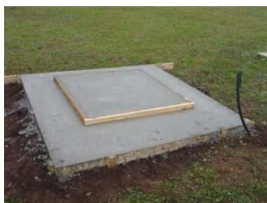
FOTO 18 – CONSTRUÇÃO DA BASE EM CONCRETO FONTE: O AUTOR (2007)
