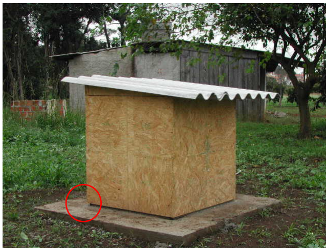
FOTO 23 – DETALHE DO ESPAÇAMENTO DOS PAINÉIS EM RELAÇÃO AO PISO FONTE: O AUTOR (2007)
