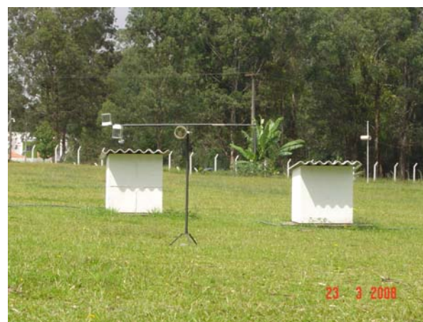
FOTO 41 – VISÃO GERAL DO SUPORTE PARA INSTALAÇÃO OS EQUIPAMENTOS DESTINADOS À MEDIÇÃO DO ALBEDO
