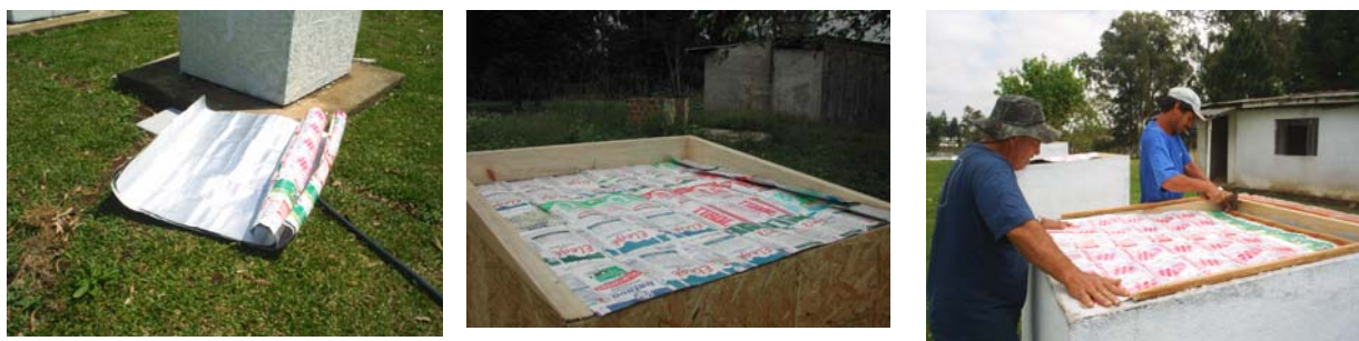
FOTO 22 – USO DA MANTA FEITA COM REAPROVEITAMENTO DE EMBALAGENS DO TIPO TETRAPAK FONTE: O AUTOR (2007)
