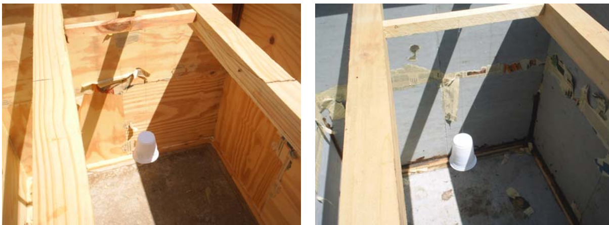
FOTO 26 – COLOCAÇÃO DOS HOBOS NO INTERIOR DOS PROTÓTIPOS FONTE: O AUTOR (2007)
