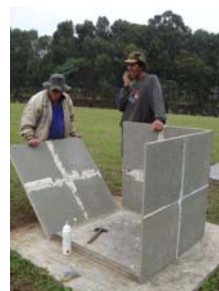
FOTO 19 – MONTAGEM DOS PAINÉIS
