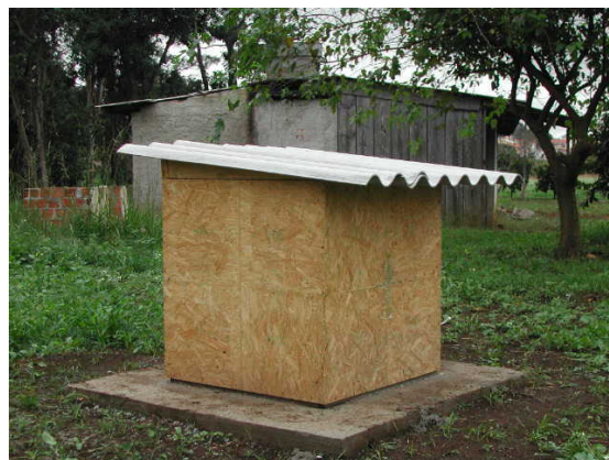
FOTO 17 - FOTO DO PROTÓTIPO CONSTRUIDO
