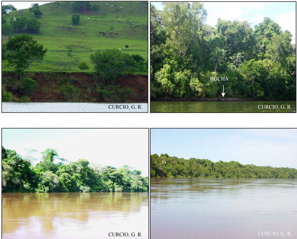
Figura 102 – A - Desbarrancamento de margem devido ao processo de erosão acelerada; B – Afloramento de rocha em superfície de degradação do subcompartimento Capanema; C - Floresta em superfície de agradação no subcompartimento Capanema; D - Aspecto de superfície de degradação no subcompartimento Capanema.
