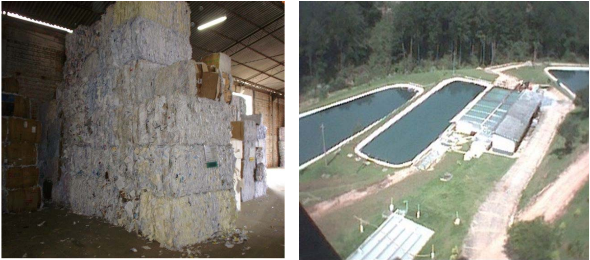
FIGURA 4 - DEPÓSITO DE APARAS E ESTAÇÃO DE TRATAMENTO DE EFLUENTES DA CVG
