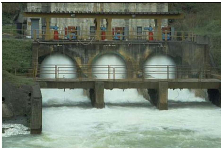
Figura 10 -Chegada da água bruta à ETA Guaraú
