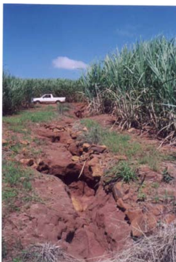
Figura 37 - Degradação do solo com afloramento de rochas causada por erosão hídrica na microbacia do Ribeirão São João (Mineiros do Tietê, SP)
